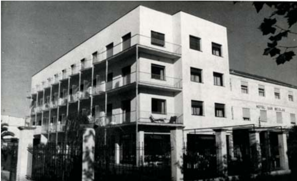
(Fig.1) Aspecto exterior Hotel San Nicolás (Revista Nueva Forma Nº 45, año 1969)
